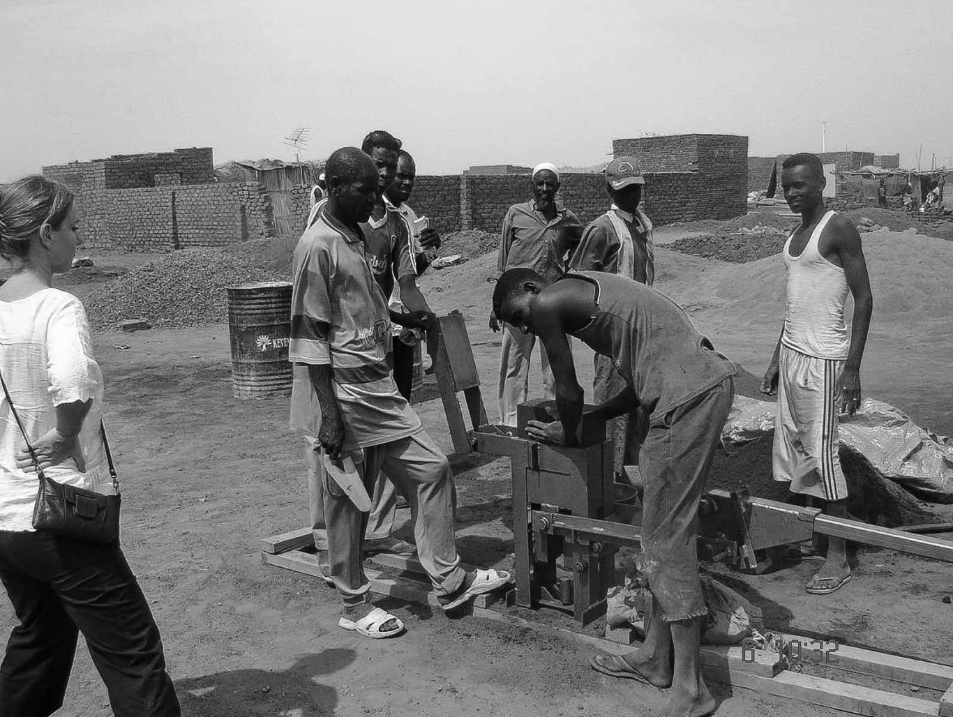
Figura 13 Prensa manual para producir bloques de suelo-cemento y barrios construidos con este material en Darfur.
