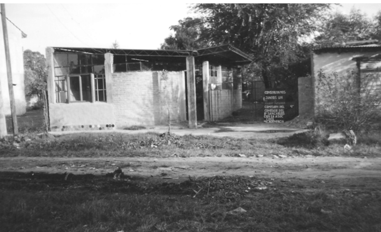
Figura 3 Interior y exterior del foco de progreso en el barrio San Carlos, Moreno
